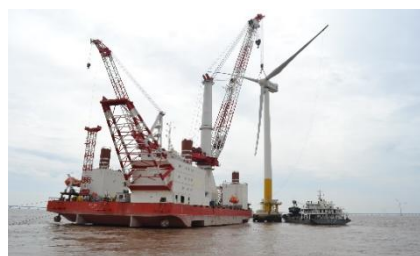
图 1 海上风电安装作业平台图 2 海上风电安装作业平台施工现场
